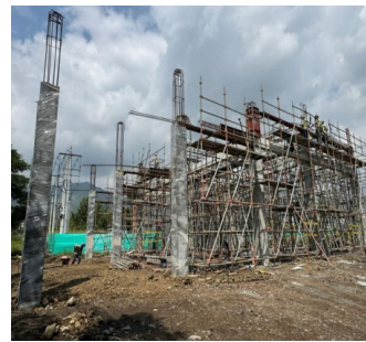
Fachada lateral derecha (octubre)
