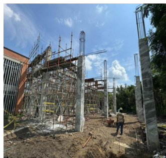
Fachada lateral izquierda (octubre)
