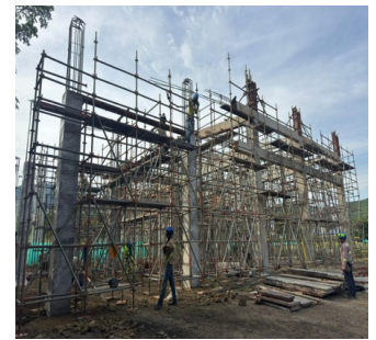
Fachada lateral derecha (diciembre)
